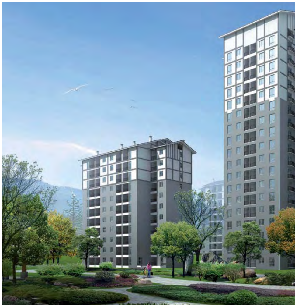
Первое жилое здание в китайском городе Дуцзяньянье, построенное целиком из стали
